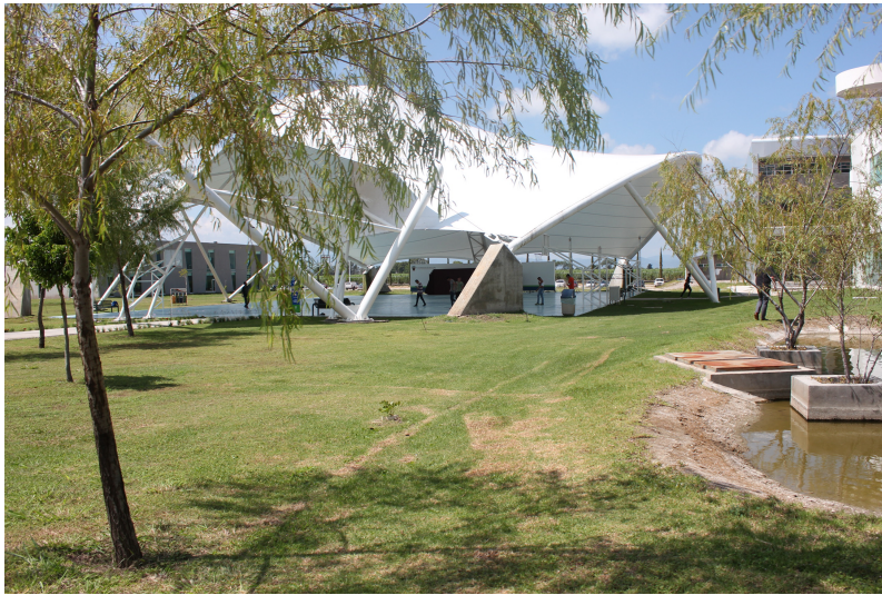
Figura 2. Instalaciones generales de CUVALLES
