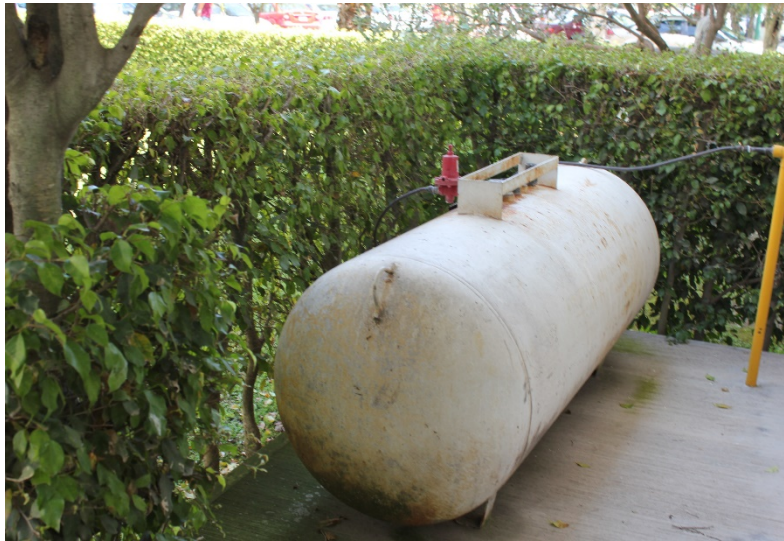
Figura 7. Instalaciones de almacenamiento de Gas LP en CUAAD.
